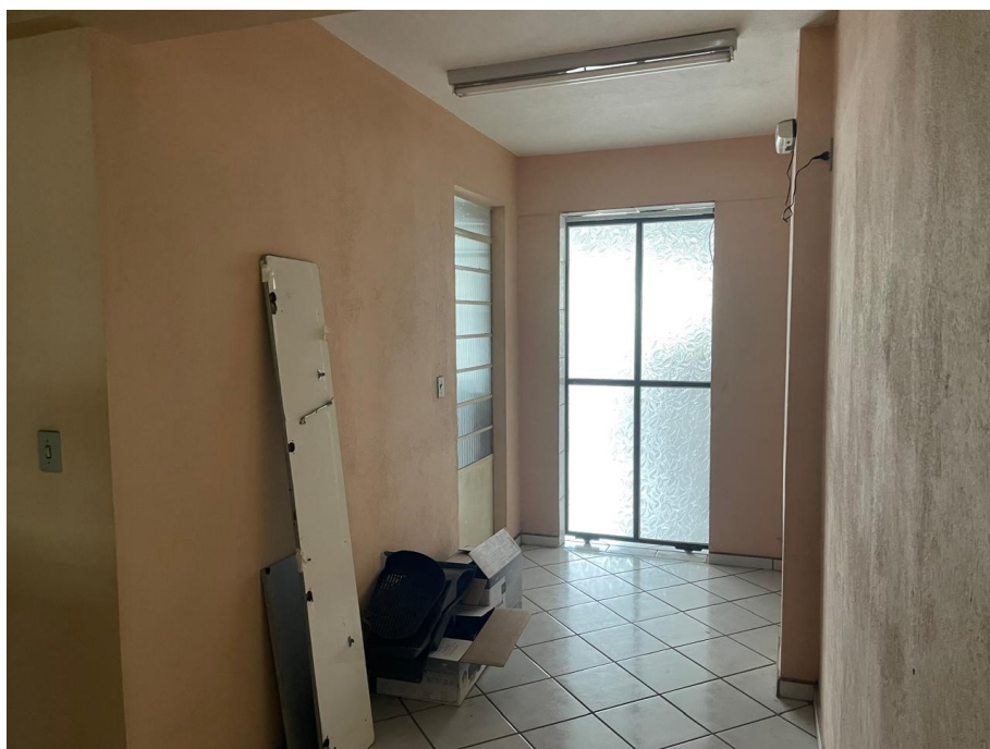
Vista do hall no pavimento superior
