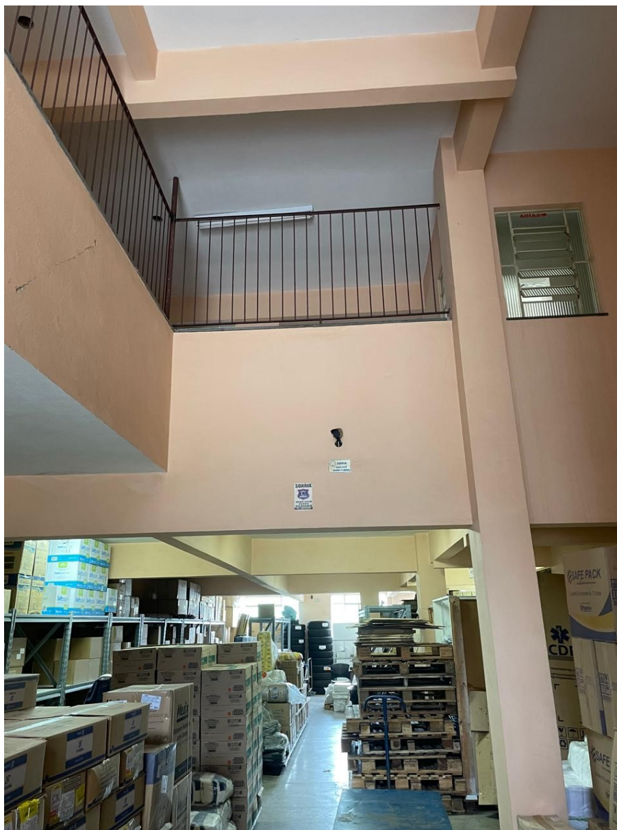
Vista dos pavimentos inferior e superior integrados por uma área com pé-direito duplo
